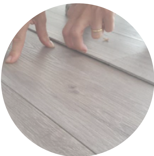
Piso que no tiene la dilatación correspondiente, esto hace que se descalce el click
