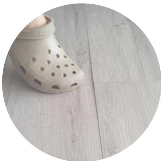
Piso instalado con una manta no adecuada
